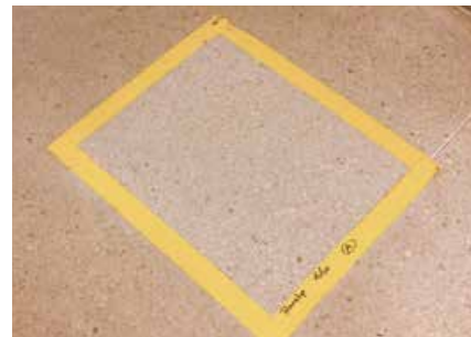
Provslipning av golv.
