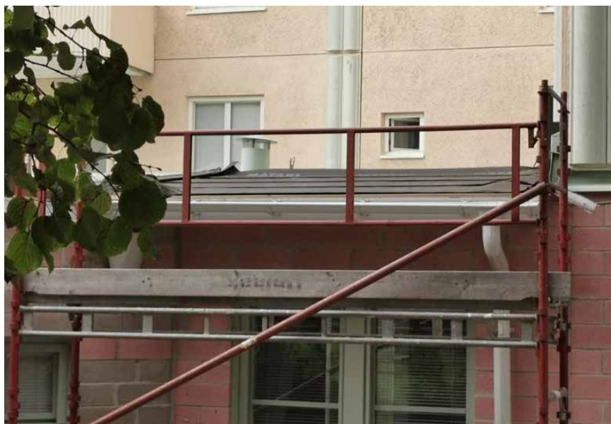
Arkens tak renoveras.
